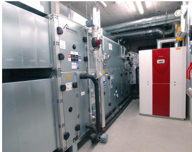
Die Sole-Wärmepumpe garantiert einen energiesparenden Betrieb mit Erdwärme. Das Lüftungsgerät in modul a-Bauweise gewährleistet die kontrollierte Be- und Entlüftung der Räume mit hohem Wärmerückgewinnungsgrad.
